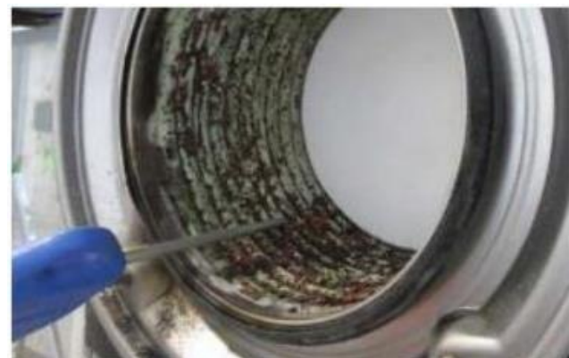
4. Fújja ki a hőcserélő spirálok közötti tereket nagy nyomású levegővel.
