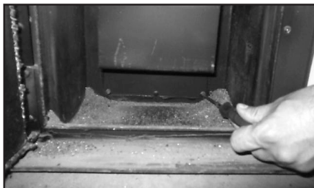
Ábra 11. A csőköteges hőcserélő kitakarítása az égő alatta lévő revíziós nyílásról elvégezhető.(modell 13 Kw)
